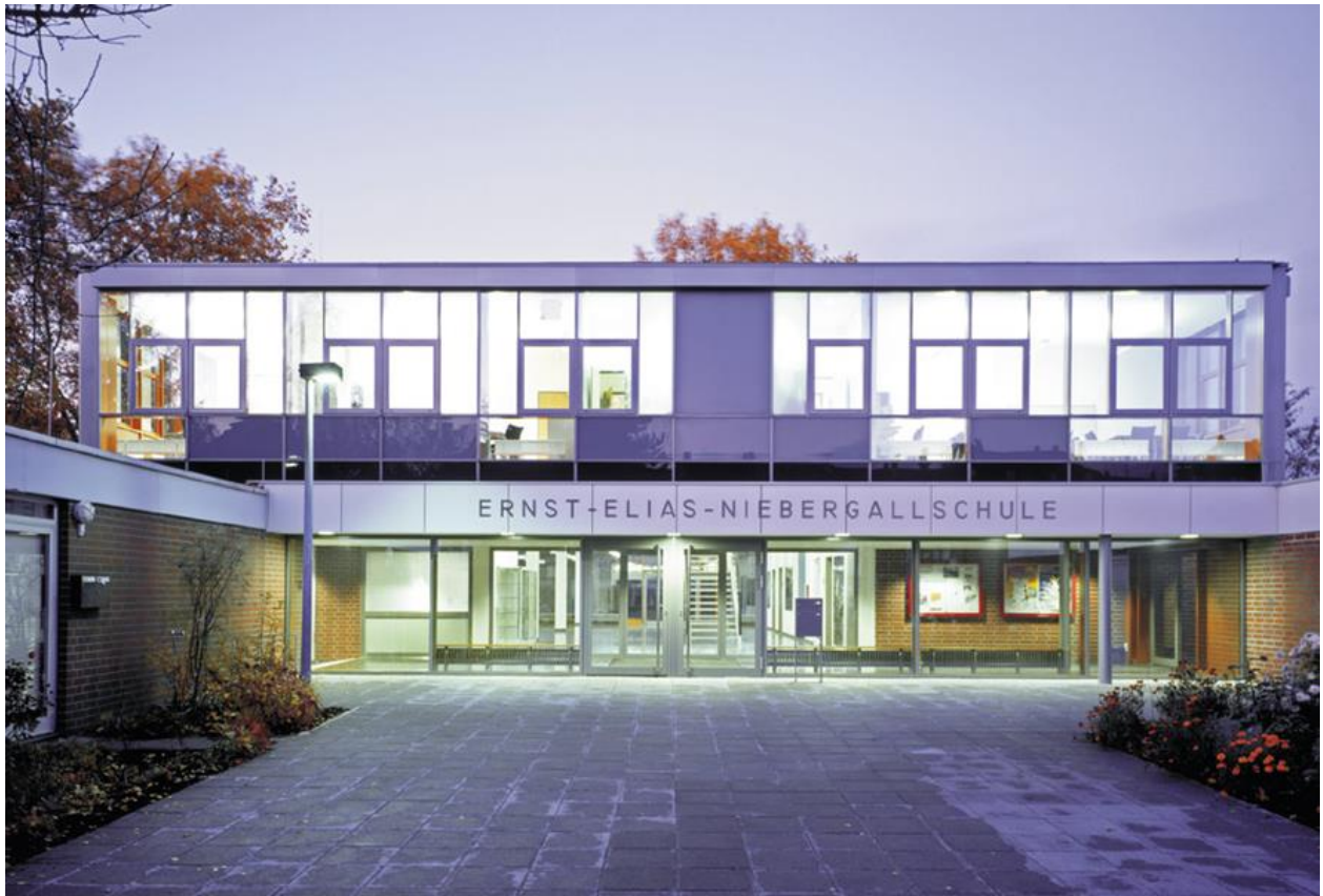
Aufgestockter und sanierter Verwaltungstrakt BT A , 2007
