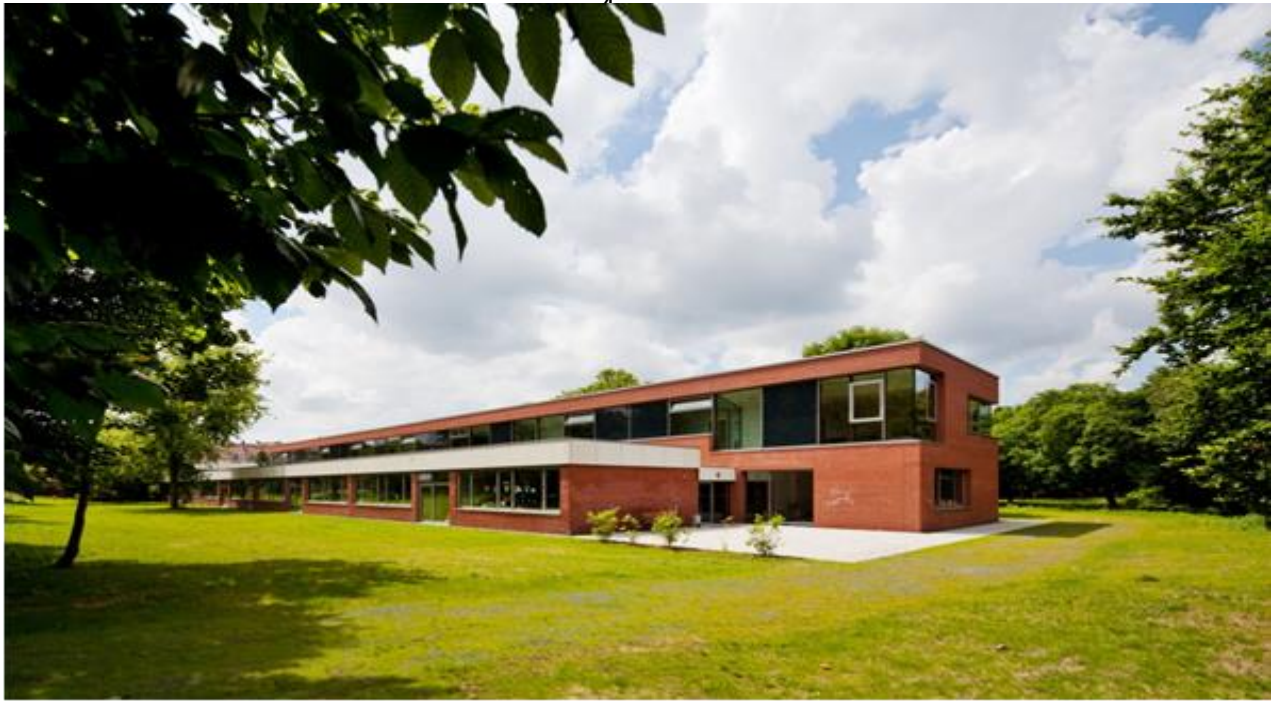
An- und überbauter östlicher Klassentrakt (BT F), 2010
