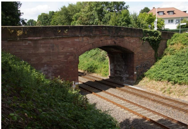
BILD 1: Ansicht aus Richtung Ostbahnhof
