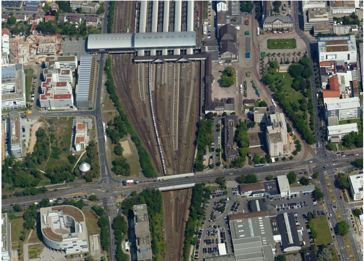
Abbildung 2:Luftbild Rheinstraßenbrücke Bestandssituation
