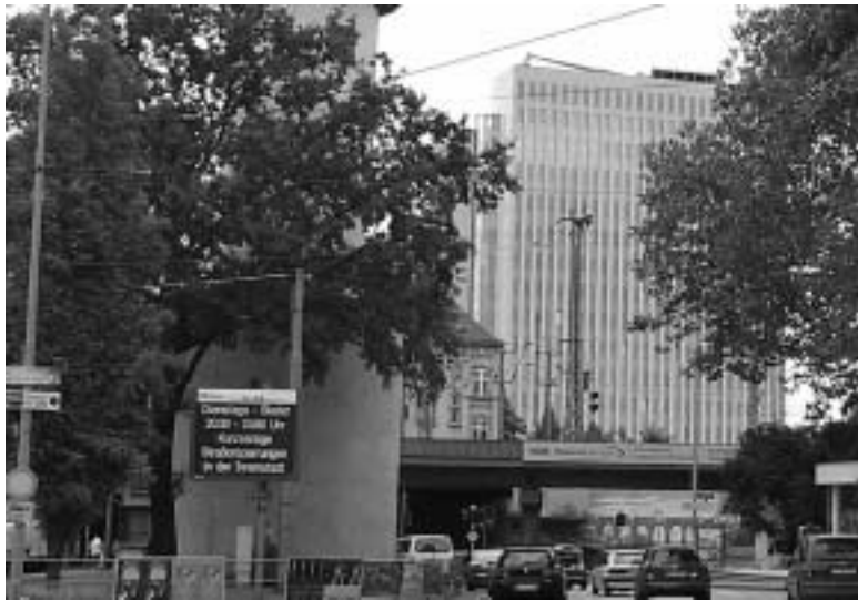
Beispiel für eine Anlage an der Galluswarte in Frankfurt am Main
