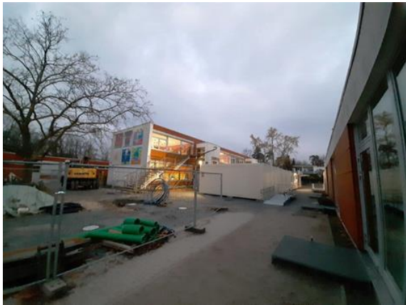
Containeranlage und Klassentrakt von Süden
