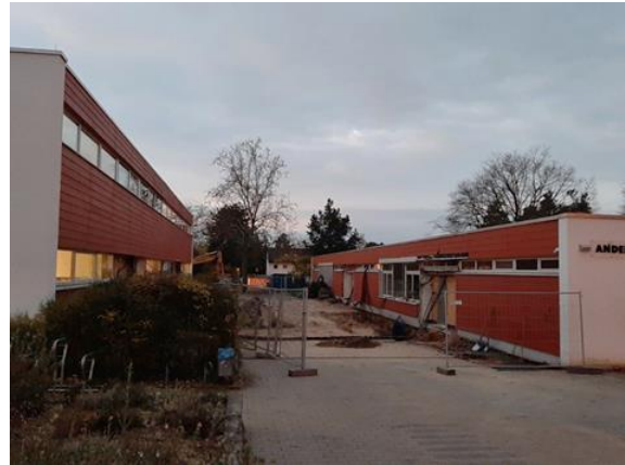
Abbruch Zwischenriegel, zukünftiger Haupteingang Nord
