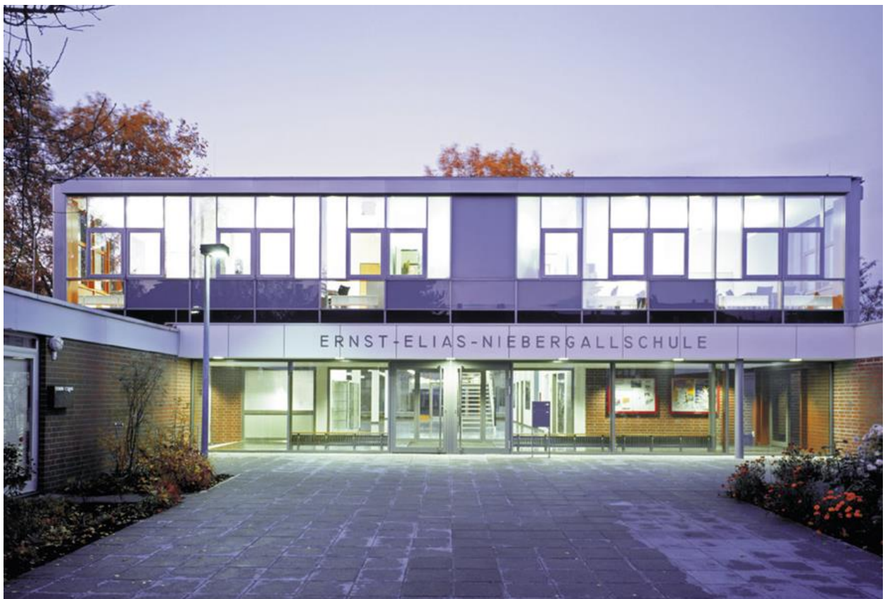
Aufgestockter und sanierter Verwaltungstrakt BT A , 2007
